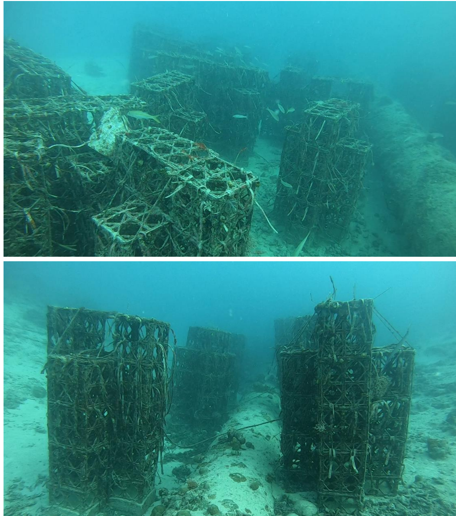
Gambar 5.1 Gambaran umum kondisi rumah ikan ( fish apartment ) pada Juni 2022; semua modul masih berdiri kokoh dan dalam kondisi yang baik (Survei primer, 2022)
